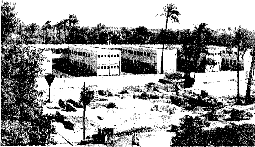
مباني مدرسة خياط للبنات
